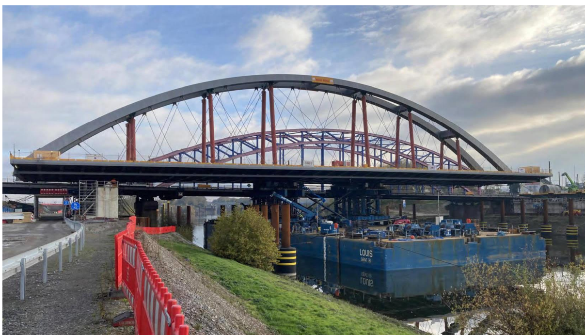
Most Hafenkanabrücke na pontonu (zdroj: Max Bögl)
