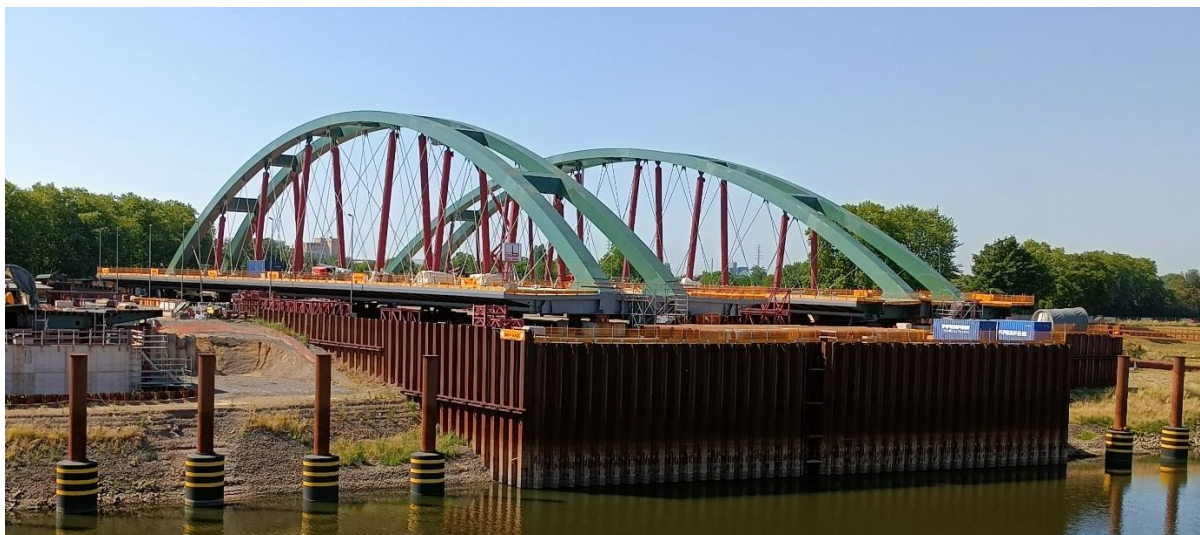
Mosty Ruhrbrücke a Hafenkanabrücke na předmontážní plošině
